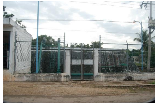
Centro de bombeo de agua potable
